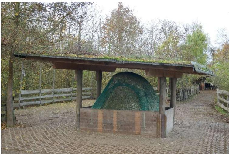
*Abb. 8: Heuraufe als einfache Holzkonstruktion mit Dachbegrünung*
