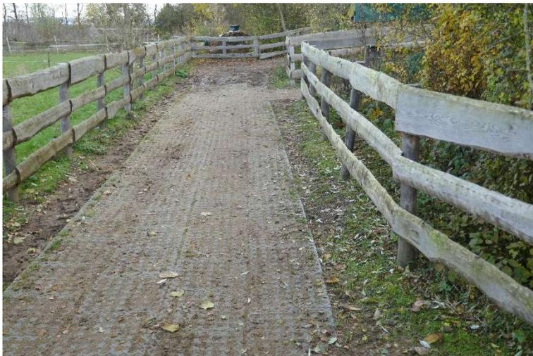
*Abb. 9: Versickerungsfähige Paddockplatten ohne Unterbau*
